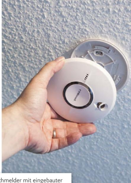
Rauchmelder mit eingebauter Langzeitbatterie sind die besten im Test – und komfortabler.
