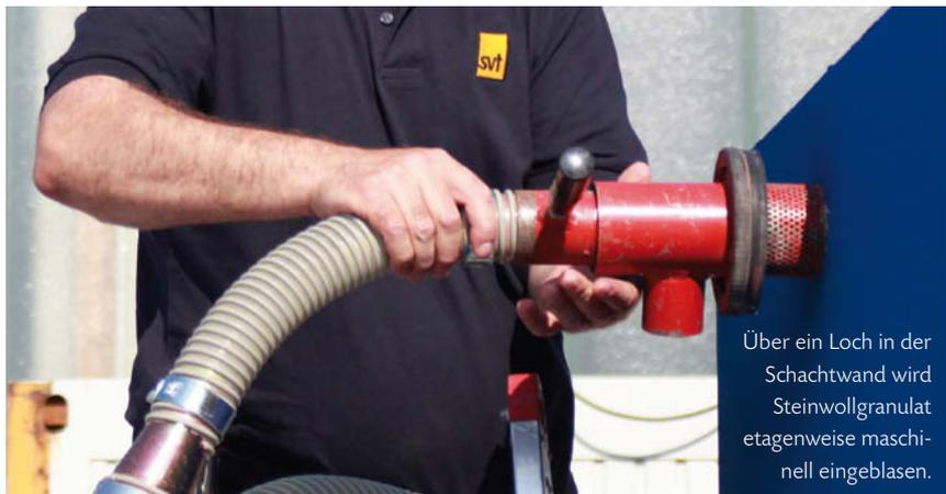
Über ein Loch in der Schachtwand wird Steinwollgranulat etagenweise maschinell eingeblasen.
