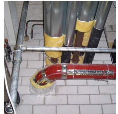
Verwendung falscher Dämmmaterialien Schmelzpunkt < 1000 °C
