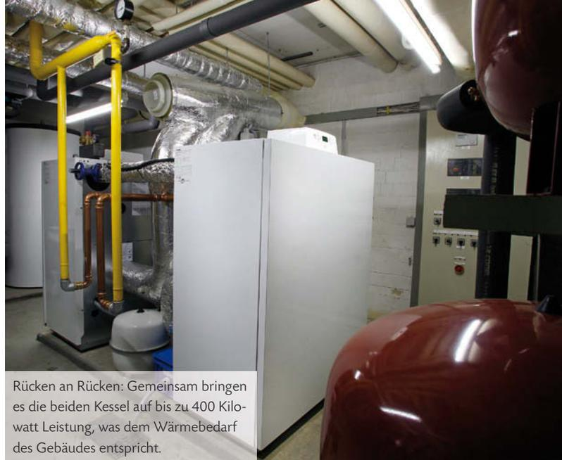
Rücken an Rücken: Gemeinsam bringen es die beiden Kessel auf bis zu 400 Kilowatt Leistung, was dem Wärmebedarf des Gebäudes entspricht.
