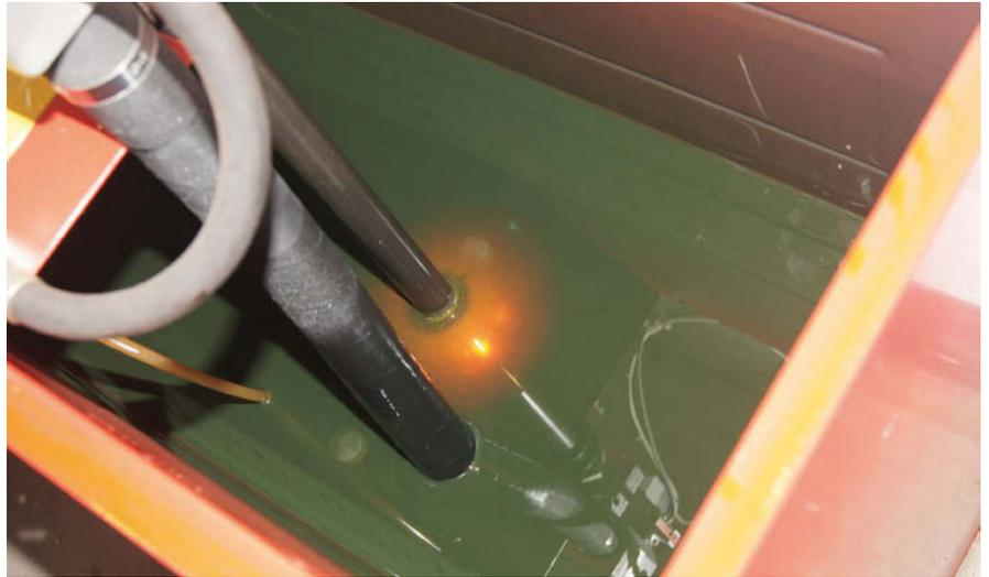
Selten angeboten, aber machbar: Das Öl in der Hydraulik des Aufzugs kann man filtrieren, den teuren Ölwechsel damit u. U. um Jahre verschieben.
