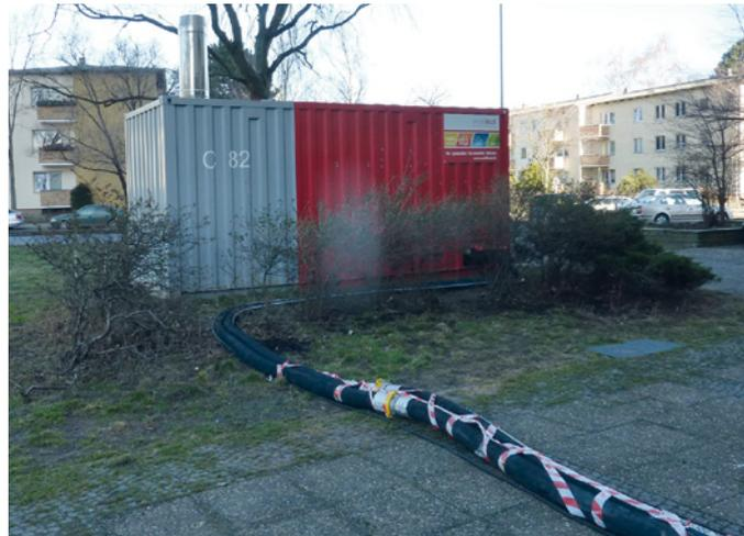
Rettung in der Not: Über eine Schlauchleitung wird das Wohnhaus aus dem Container mit Wärme versorgt.
