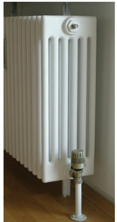
Waagrechte Einrohrheizung mit Rohrleitung im Estrich
