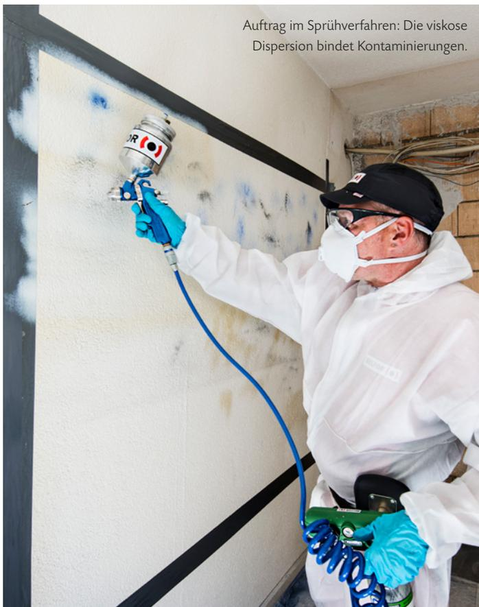
Auftrag im Sprühverfahren: Die viskose Dispersion bindet Kontaminierungen.
