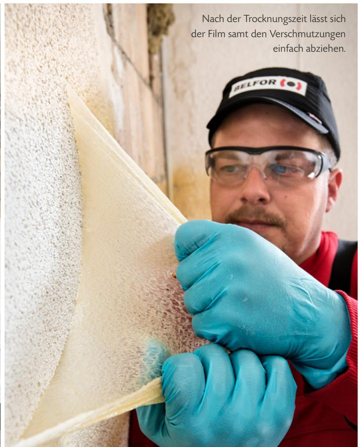
Nach der Trocknungszeit lässt sich der Film samt den Verschmutzungen einfach abziehen.
