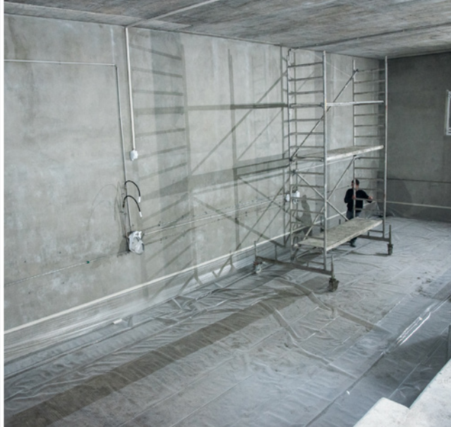
Grube der demontierten Parkanlage
