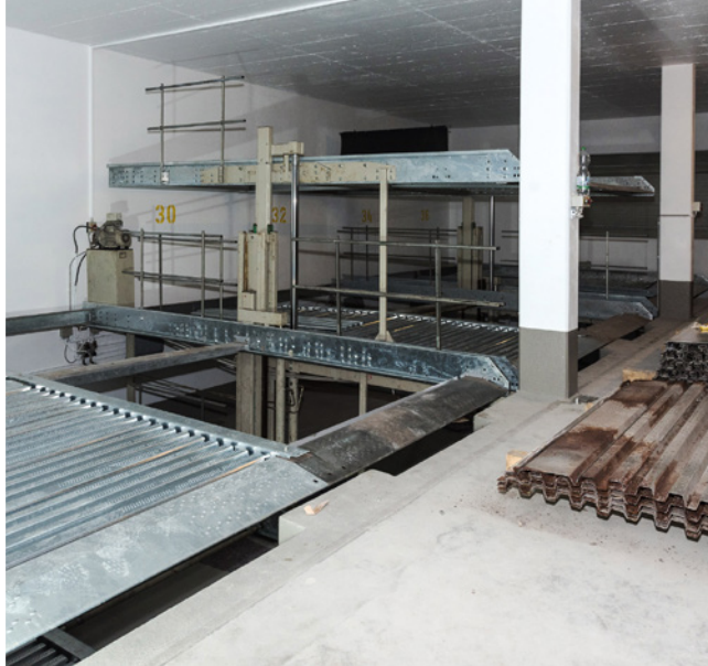
Wiedereinbau der Doppelparker
