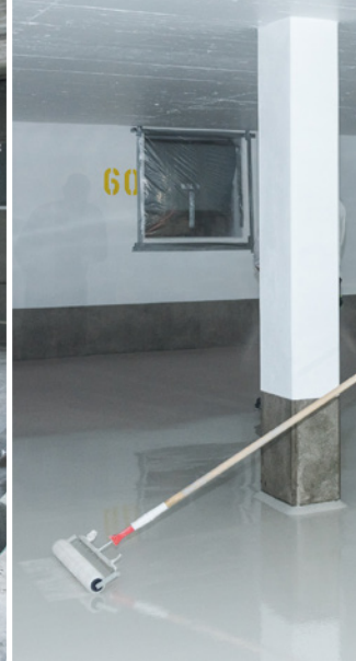
Aufbringen der Bodenbeschichtung
