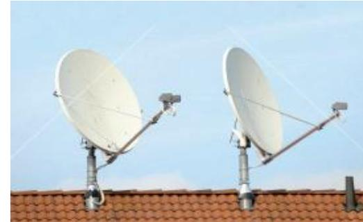
Die digitalen Übertragungskanäle haben Frequenzbereiche bis 2GHz, deshalb ist ein 4fach abgeschirmtes Kabel zu empfehlen. Die richtigen Komponenten garantieren einen optimalen Empfang. Vorteil der besseren Abschirmung ist die Verhinderung von Funk-Störungen. (z.B. Fernbedienungen, DECT-Telefonen, W-LAN)
