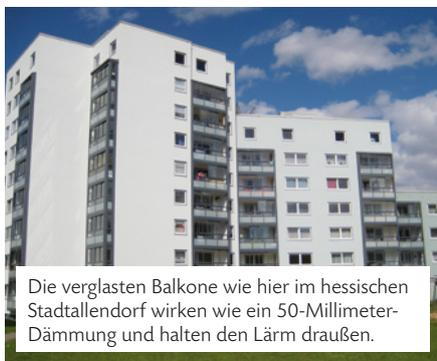
Die verglasten Balkone wie hier im hessischen Stadttalendorf wirken wie ein 50-Millimeter-Dämmung und halten den Lärm draußen.
