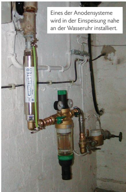
Eines der Anodensysteme wird in der Einspeisung nahe an der Wasseruhr installiert.
