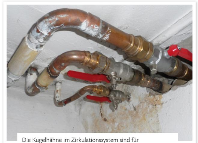
Die Kugelhähne im Zirkulationssystem sind für den hydraulischen und thermischen Abgleich nicht geeignet.
