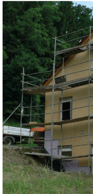
Hier entsteht ein Wärmedämmverbundsystem aus Holzfasern.
